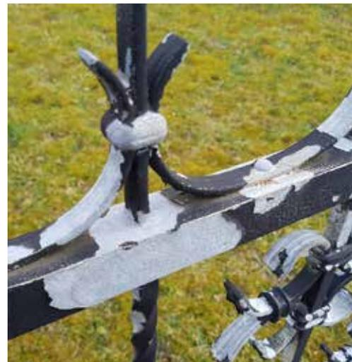
Abbildung 10: Zinkablösung nach der Beschichtung
