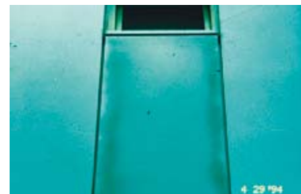
Bild 6: Bilderrahmeneffekt bei Metallic-Beschichtungen
